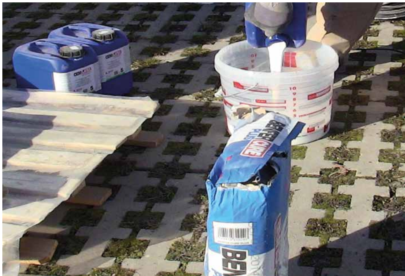
Dosaggio di CEMLATEX 600 per aumentare la deformabilità degli adesivi
