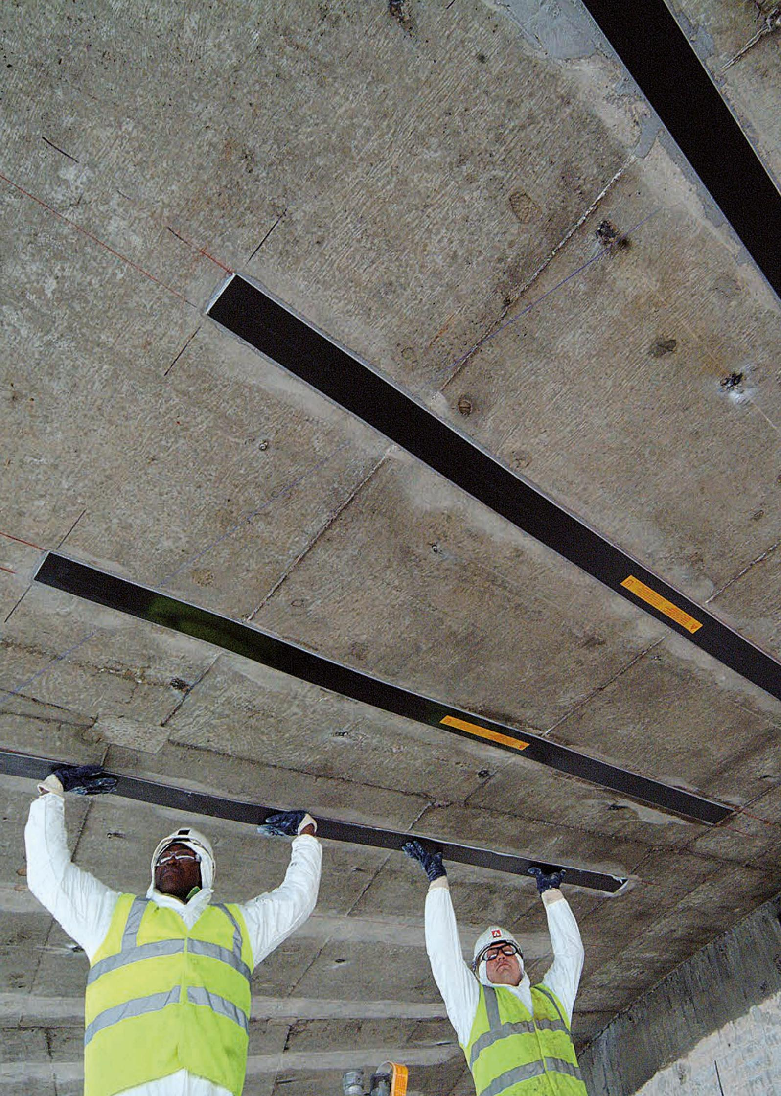
**CON GLI ADESIVI STRUTTURALI** della gamma Sikadur®, le lamine Sika® CarboDur® ed i tessuti SikaWrap® in fibra di carbonio, Sika offre notevoli possibilità nel settore del ripristino e del rinforzo strutturale di elementi costruttivi danneggiati o sottodimensionati e nell'adeguamento antisismico.
