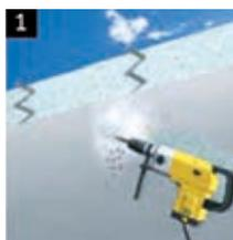
1 Asportazione del calcestruzzo danneggiato o dei resti di legno e riprofilatura delle parti danneggiate.
