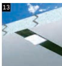
13 Pulizia delle lamine Sika® CarboDur® in CFRP dalla parte levigata con un panno bianco e Pulitore. Applicazione di un ponte adesivo, ad es. Sikadur®-30 oppure Sikadur®-330 con sabbia quarzifera.
