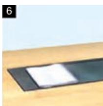
6 Pulizia delle lamine in CFRP Sika® CarboDur® con un panno bianco e pulitore specifico. Indossare occhiali e guanti di protezione! Lasciare asciugare per almeno 10 minuti!
